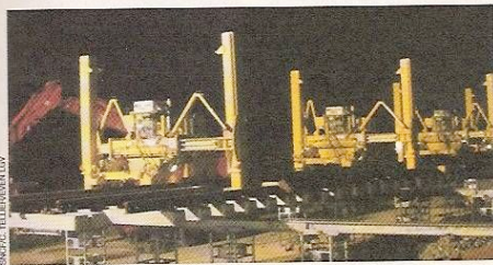
Ripage de l'aiguillage qui pèse plus de 200 tonnes.
