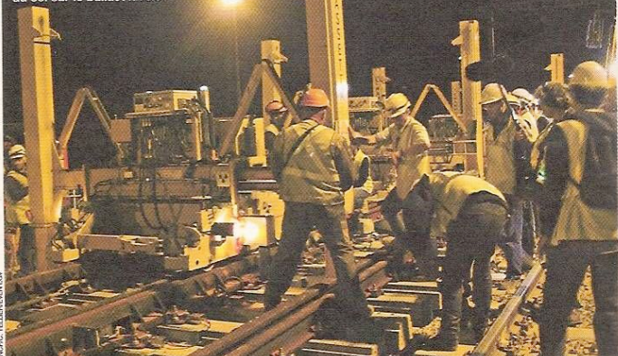
Le nouvel aiguillage est déposé au sol sur le ballast nivelé.
