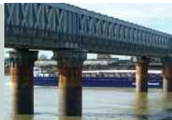
Le pont ferré sur la Garonne compte désormais quatre voies.
