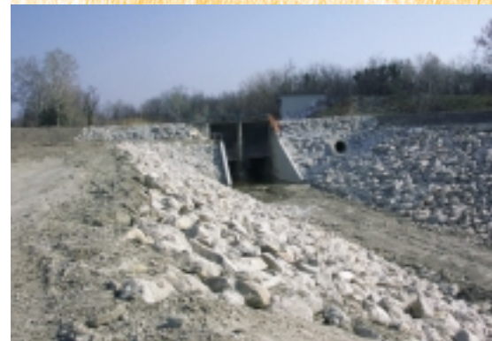
Enrochements aux normes CE pour le chantier de Tarascon.
