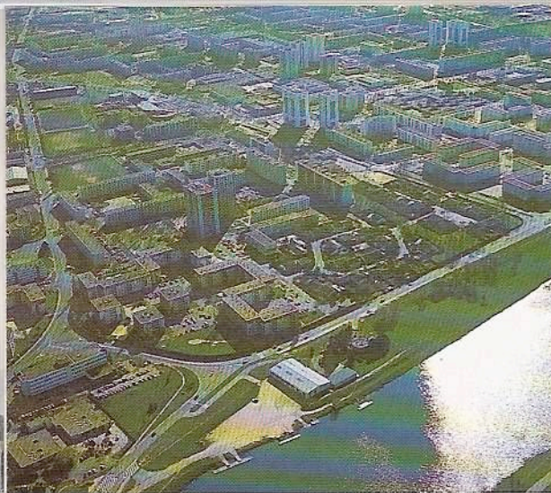
Le quartier du Val Fourré fait partie des projets de revalorisation urbaine du CDU de Mantes-en-Yvelines.
