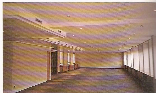
Comme dans cet immeuble de la rue de Villiers, à Levallois-Perret, les investisseurs n'hésitent pas à restructurer les espaces pour créer des plateaux conformes aux exigences des entreprises.
